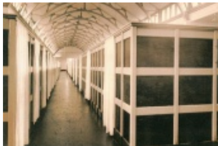
De chambretjes op de slaapzaal
