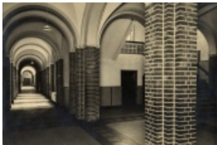
De kapelgang met rechts de trap naar de slaapzaal
